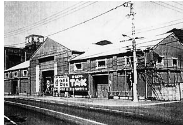
呉貿倉庫運輸(株)3号倉庫(造兵廠製品 置場、大砲庫及び魚形水雷調整室)
